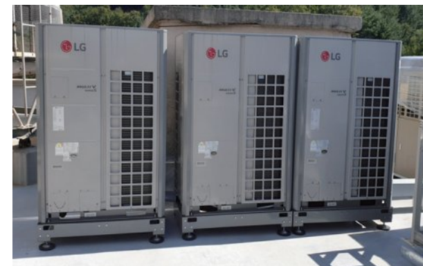
냉난방 설치 사진
