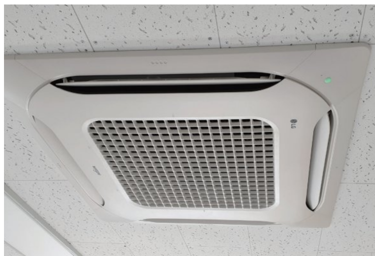
냉난방 설치 사진
